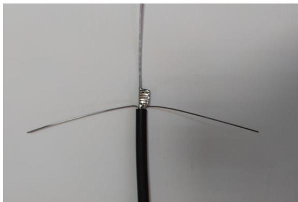
3.3 Для забезпечення безперервності екрану необхідно зробити продольний надріз оболонки кабелю довжиною 25 мм від її краю. За допомогою інструменту зніміть оболонку не пошкоджуючи стальну гофротрубку. З'єднайте стальну гофротрубку з
